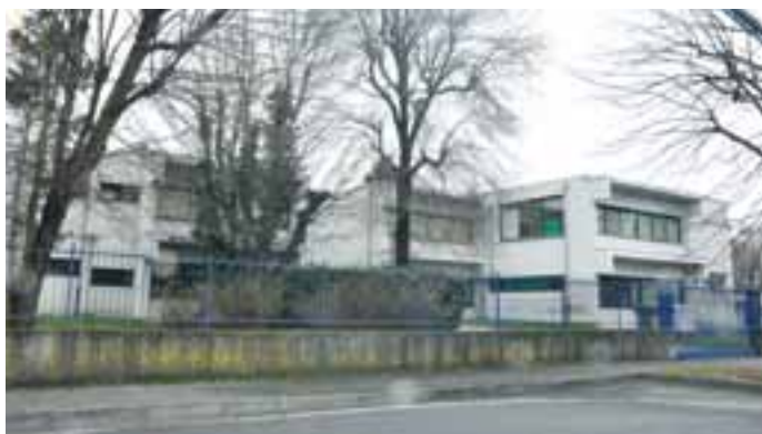
Scuola primaria Bustighera
