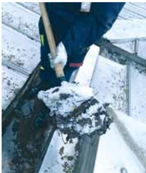
**I**volontari sui tetti delle scuole a spalare la grandine dai canali di gronda, totalmente intasati e ghiacciati tanto da non far defluire l’acqua dai normali pluviali provocando infiltrazioni negli edifici. Le condizioni climatiche sempre più estreme ed improvvise richiedono un’attenzione e una rapidità di intervento sempre maggiore ecco perché ci stiamo strutturando ad avere una squadra di Pronto intervento.
