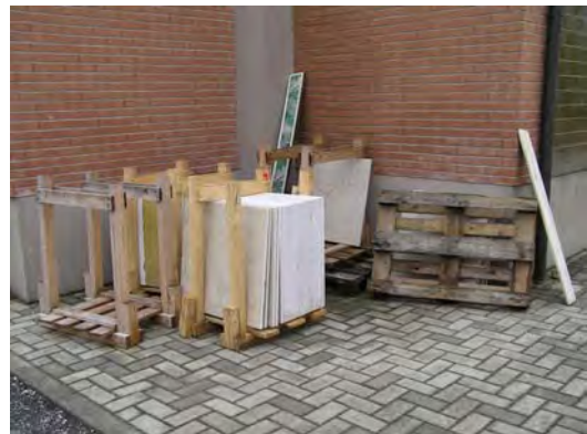
Deposito non recintato non ammissibile
