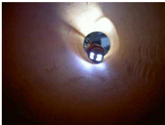
Ingresso di una telecamera in tubazione
