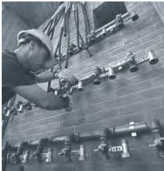
Rubinetti gas predisposti per allaccio contatori- Anno 1988 (Fonte: CPL Concordia).
