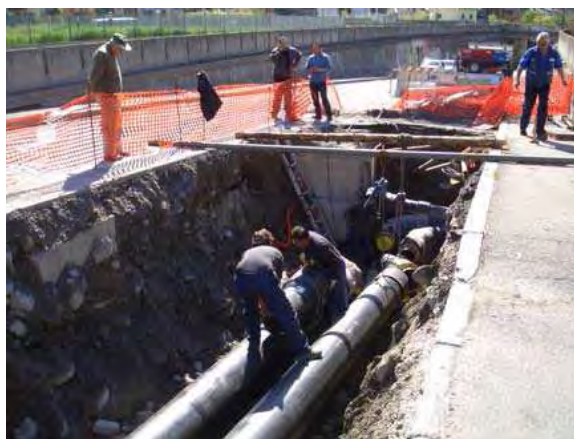
Posa di tubi del teleriscaldamento
