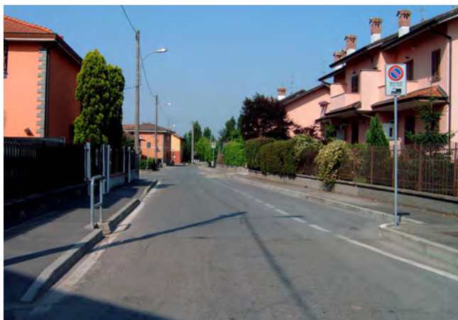
Marciapiede di Via Marconi – Frazione di San Martino Olearo
