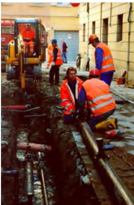
Intervento di manutenzione straordinaria sui sottoservizi
